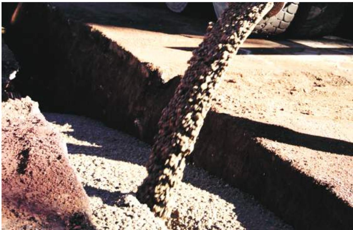
Colma facilmente gli eventuali sgrottamenti dello scavo e non necessita di alcuna azione di compattazione dopo il getto in opera. L'elevata velocità operativa all'atto della sua messa in opera consente la riduzione dell'impatto dei mezzi d'opera sul traffico e dei tempi di chiusura degli scavi con conseguente riduzione dei costi nell'esecuzione dei lavori.
