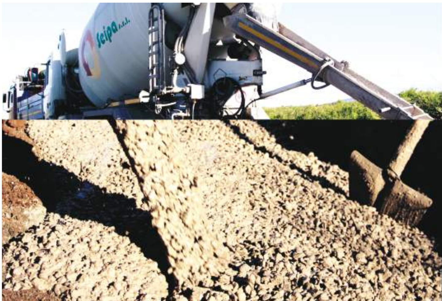
La miscela viene confezionata con soli aggregati provenienti dal processo di recupero C&D (Construction & Demolition), cemento pozzolanico, additivo schiumogeno ed acqua, e viene poi miscelata, trasportata e gettata in opera con autobetoniera.
